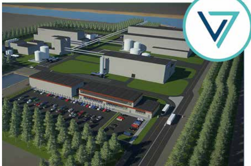
Am Geothermie-Kraaftwierk vun der Firma Vulcan Energie zu Insheim bei Landau in der Pfalz gëtt de Lithium aus dem waarme Geothermie-Waasser gewonnen © Foto: Vulcan Energie
