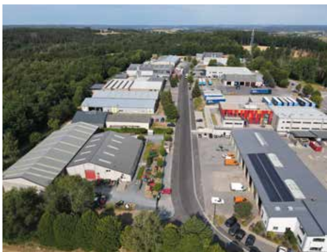
La ZA Riesenhaff avec son nouveau revêtement de voirie. © SIRK
