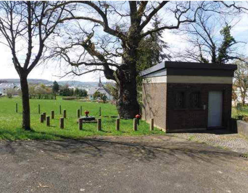
D'Béik Quelle vu Kaalmes mat Pompelstatioun. © DEA
