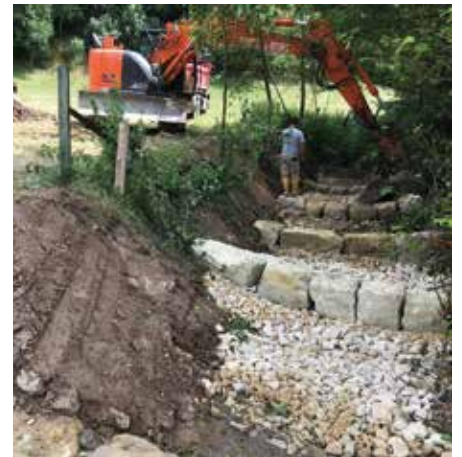
D'Leeë vun de Steng fir eng Ramp ze forméieren Pose des pierres pour former la rampe
