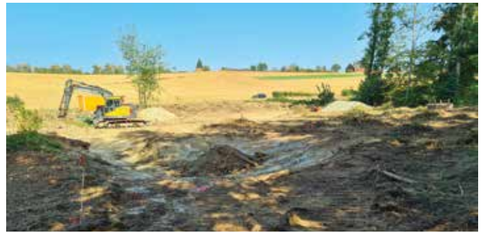
De Site bei de Baggerarbeiten an dësem Hierscht. Dobäi goufen nitt nëmmen zwee Dämpelen ugeluecht, déi Amphibië Liewensraum bidden, mee gläichzäiteg och eng Rei Depressiounen ausgebagert an déi d'Turelbaach bei Héichwaasser ka lafen. Esou entstinn engersäits Fiichtflächen a gläichzäiteg gëtt fir eng Waasserréckhaltung gesuergt, déi Iwwerschwemmungen ënnerhalb reduzéiert.
