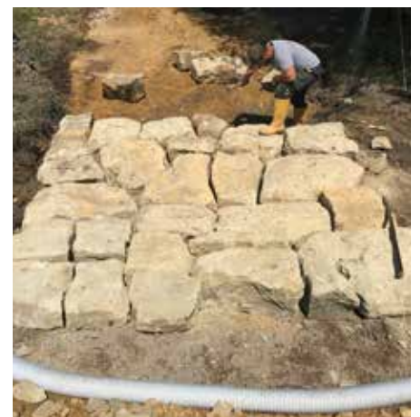
D'Tässelen vun de grouse Bléck fir de Fong vun der Fuert ze schafen Imbrication des grosses pierres pour former le fond du gué
