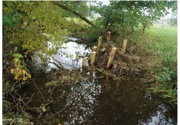
Hëlze Péil am Baachverlaf hëllefen d'Stréimung ëmzelenken. Duerch leeft d'Waasser méi lues of a gëtt bei liichtem Héichwaasser éischer op d'Projetsfläch gelenkt. Ausserdeem fänkt d'Baach un erëm natierlech Mäanderen auszebilden a kritt e méi naturnoe Laf.
