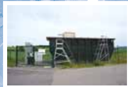
PROVISORESCH KLÄRANLAG SOLUPLA
