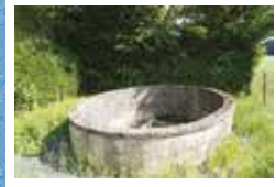
MECHANESCH KLÄRANLAG OSPER
