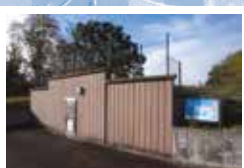
WAASSERBEHÄLTER OP DER RÉINK
