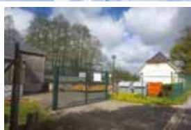
BIOGESCH KLÄRANLAG NIDDERKOLPECH
