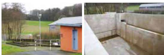
AL BIOLOGESCH KLÄRANLAG GROUSSBUS & NEI POMPELSTATION GROUSSBUS
