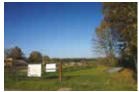
MECHANESCH KLÄRANLAG LEEWEL
